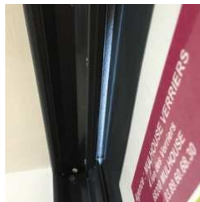
La sortie de secours 1 er étage
